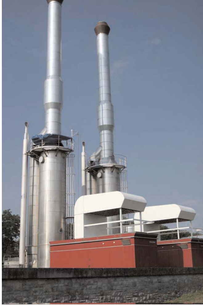
محطة لتوليد التيار الكهربائي المتغير
