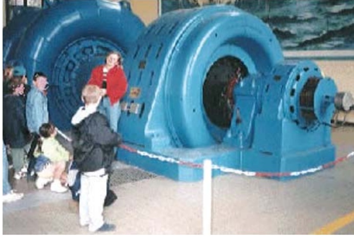
مولد لمحطة توليد طاقة كهربائية
