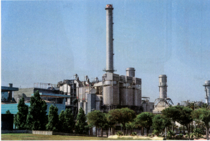
محطة توليد الكهرباء بحرق النفايات في اليابان
